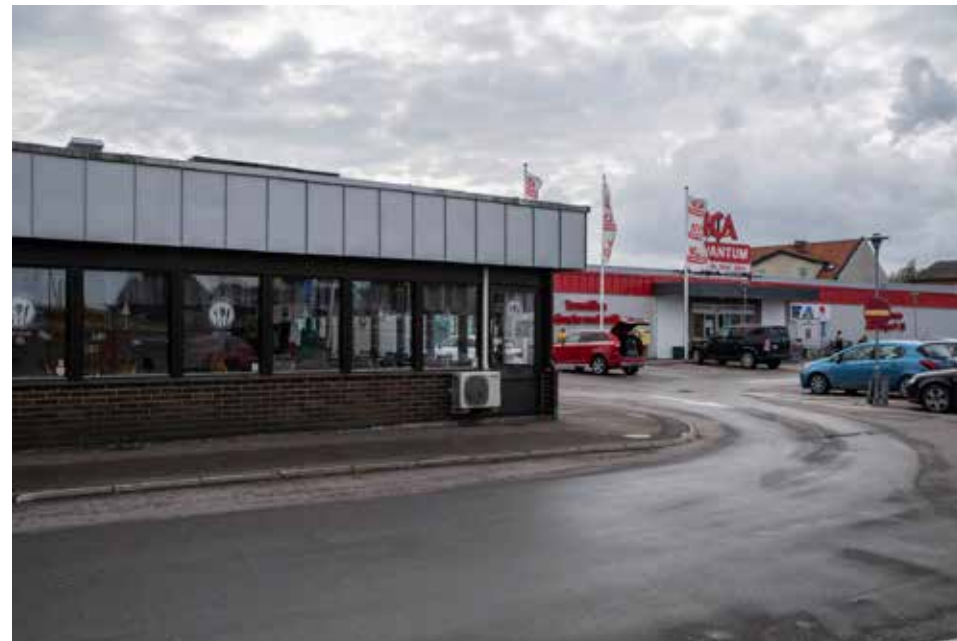
Restaurangbyggnaden på parkeringen i söder.
