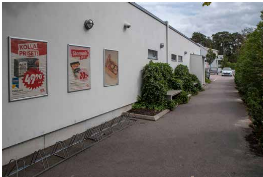
Södra fasaden på butiken är välvårdad med cykelställ, sittplatser och klättrväxter.
