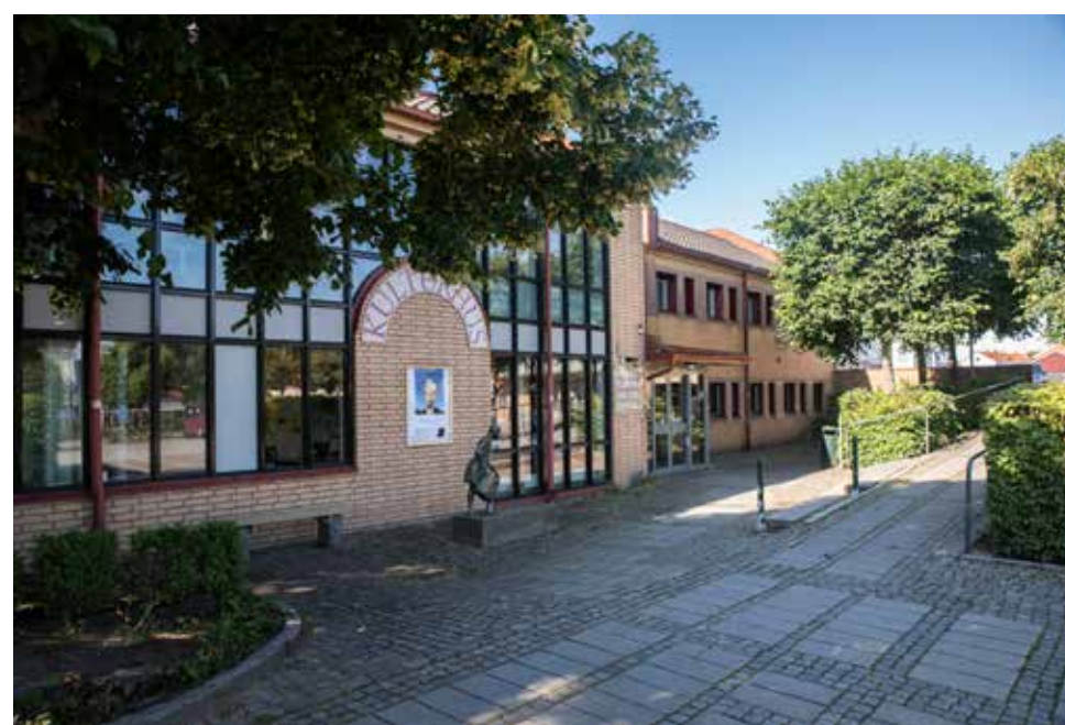
Kulturhuset i sydvästra delen av torget.
