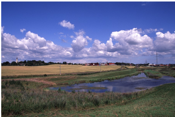
Nyskapade dammar intill Ystadbanan för att rena vattnet och utjämna vattenflöden.
