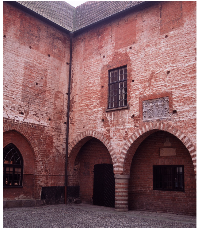
Borggården på Torups slott. Spår efter äldre fönstersättningar syns i murarna. Under valvet fanns förr ett vagnslider men sedan slutet av 1800-talet bibliotek.
